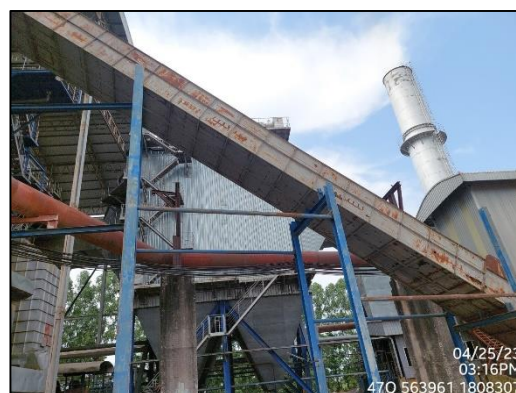
ภาพที่ 23 ระบบสายพานลำเลียงถ่านแบบระบบปิด
