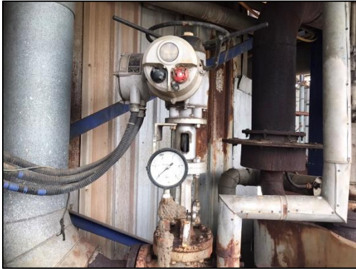
ภาพที่ 66 ติดตั้งชุด Bypass valve เพื่อลดความดันของไอน้ำ
