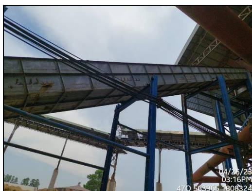
ภาพที่ 23 ระบบสายพานลำเลียงถ่านแบบระบบปิด
