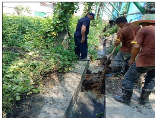
ภาพที่ 28 การขุดลอกการระบายน้ำ
